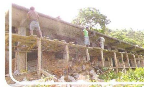
Die neue Schule, noch ist sie im Rohbau. Geplant sind 3 Etagen. 220 Kinder sollen hier unterrichtet werden.
